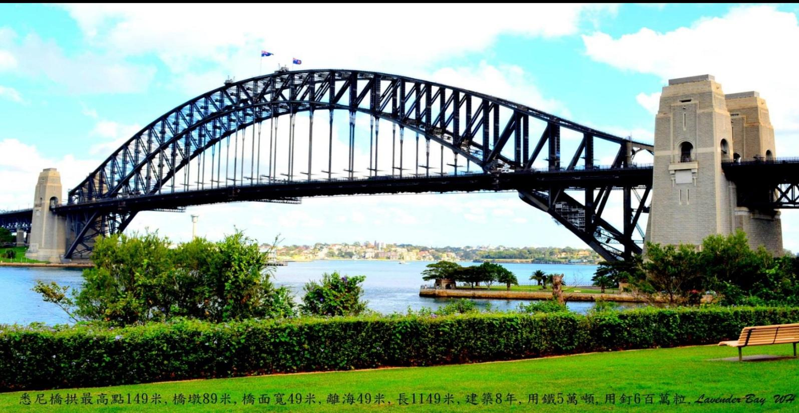
悉尼橋拱最高點149米，橋墩89米，橋面寬49米，離海49米，長1149米，建築8年，用鐵5萬噸，用釘6百萬粒，Lavender Bay WA
